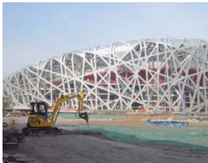
Fot. Prace budowlane na terenie głównego obiektu olimpijskiego
